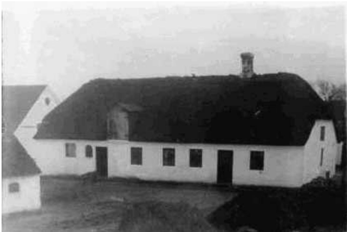
Huset på Skomager bakken i Vaarst
